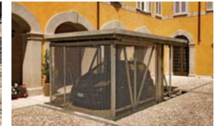
Gli impianti sono muniti di una rete di protezione anticaduta in acciaio installata sui 3 lati.
