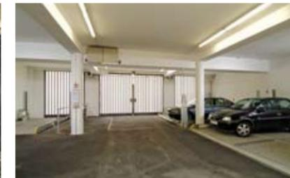
10 posti auto serie H sono stati installati nel lato sinistro e destro della corsia di manovra. Nella stessa corsia si può notare il perimetro del cappello dell'impianto modello IP1-C. La superficie è stata ricoperta di asfalto.
