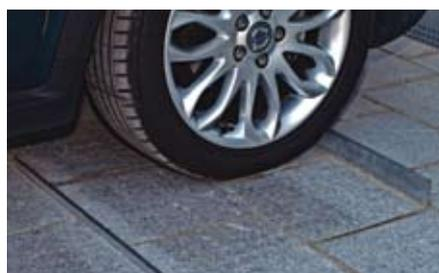
*Il fermaruote per il posto auto sopra la copertura dell'impianto, fissato ed integrato nel pavimento in pietra, è efficace e ben progettato.*
