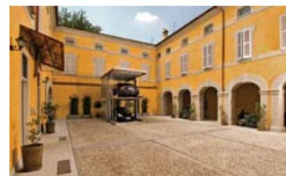
Vista del cortile con uno dei sistemi completamente sollevato e pronto per l'uscita dell'auto sul livello inferiore.
