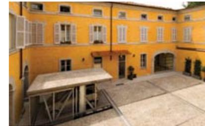
Una canalina perimetrale è stata montata su tutto il bordo del cortile e, mediante un gocciolatoio posizionato sul cappello di copertura degli impianti, garantisce la completa raccolta dell'acqua piovana. Sono comunque previsti dei pozzetti sul fondo della fossa per la raccolta di eventuale acqua che dovesse entrare nei vani durante la movimentazione.
