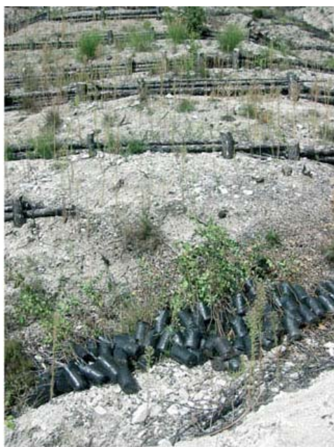
Palizzate vive in corso di realizzazione (ottobre 2003) Pizzoli (AQ) - Foto P. Cornelini
