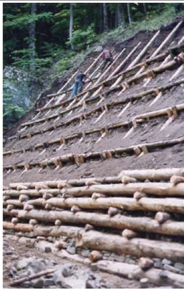
Grata viva, (2002) Reggello (FI). Foto: G. Franchi
