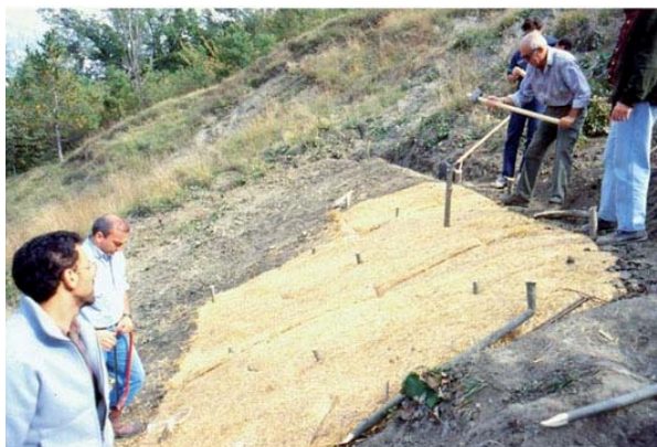
Biostuoia su argille (ottobre 1996) Anversa degli Abruzzi (AQ) - Foto P. Cornolini
