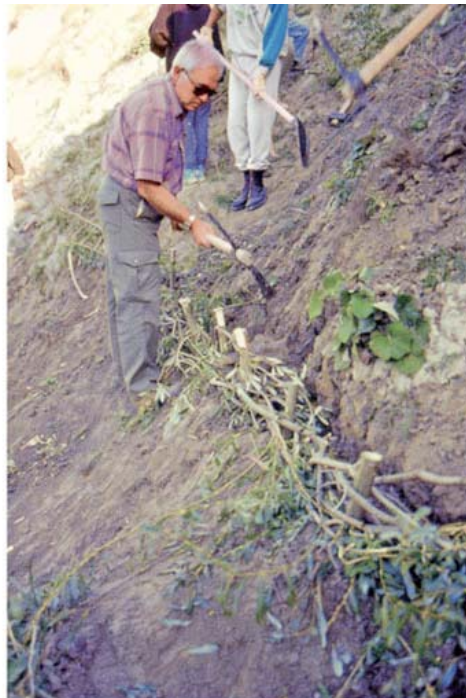
Viminata viva seminterata (ottobre 1996) Anversa degli Abruzzi (AQ) - Foto P. Cornolini
