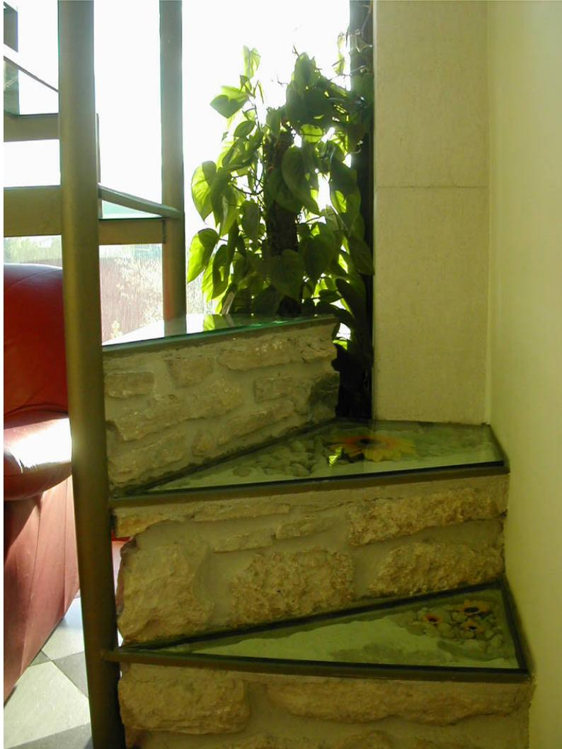
Anche in quest'ultima scala è evidente il contrasto tra antico e moderno; i primi gradini, infatti, disposti a ventaglio sono formati mediante pietre a vista recuperate durante i lavori di ristrutturazione dell'appartamento con lastre in vetro triangolare a formare le pedate. Gli spazi al di sotto delle pedate in vetro sono riempiti con pietra di fiume sapientemente illuminate per creare un suggestivo effetto visivo grazie alla trasparenza del vetro e ai riflessi che si originano.
