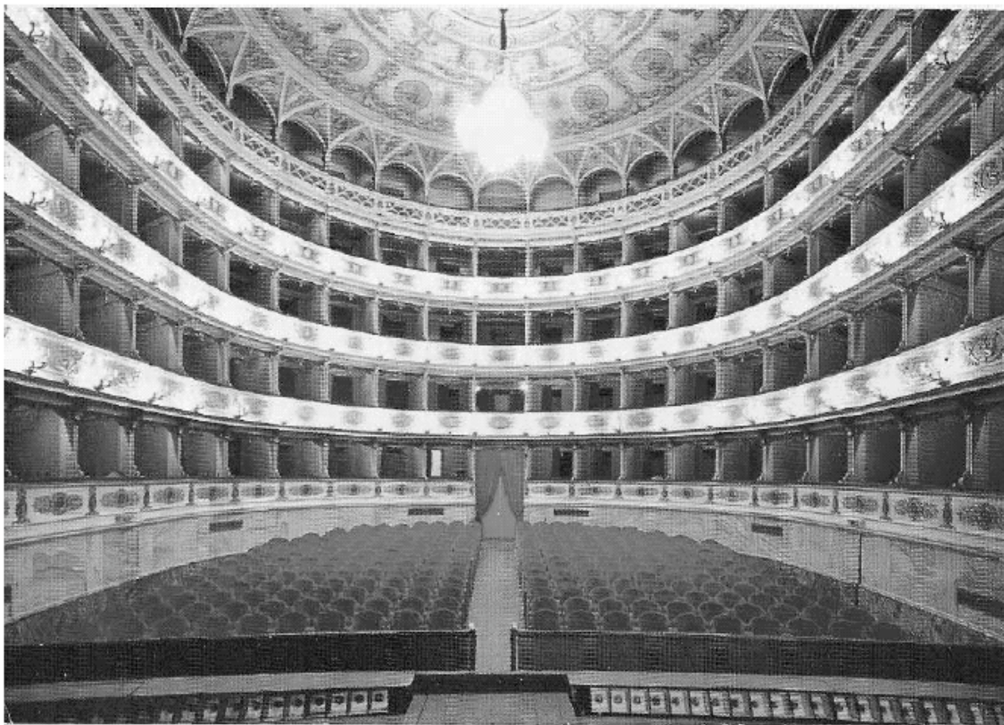
Fig.1.12. Vista d'insieme del Teatro Nuovo nella penultima fase di restauro; la sala, i quattro ordini di palchi e il loggione, ripresi dal palcoscenico.
