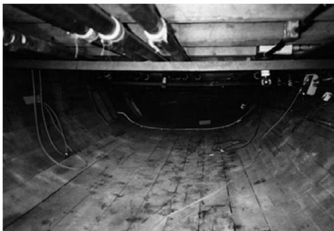
Fig. 6. La cavità collocata al di sotto della fossa d'orchestra nel teatro São Carlos di Lisbona. Attualmente la cavità viene utilizzata come cavedio per il passaggio di condotti tecnici. I rilievi acustici effettuati nell'area del palcoscenico e soprattutto nella fossa d'orchestra hanno evidenziato una variazione considerevole dei parametri acustici percepiti nella cavea teatrale a seconda della collocazione della sorgente sonora.
