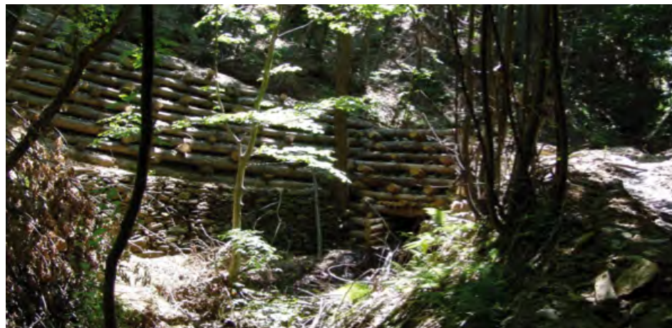
Interventi di ingegneria naturalistica
