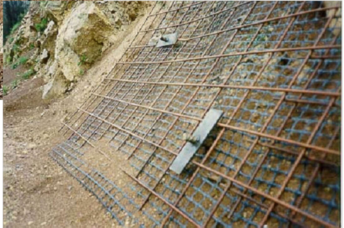
PARTICOLARE DELLE CHIODATURE SUL VERSANTE RETE E GEOGRIGLIA ANCORATE SUI CHIODI
