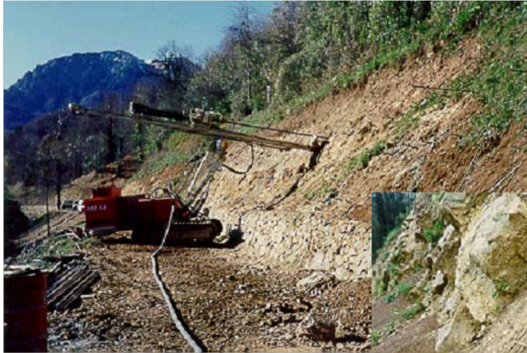
OPERAZIONE DI CHIODATURA CON MACCHINA OPERATRICE SPECIALE
