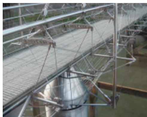
Tiranti disposti a ventaglio sorreggono il ponte pedonale rotante.
