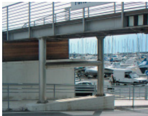
I tralicci con sezione ad H sostengono la struttura e accorciano la luce del ponte.
