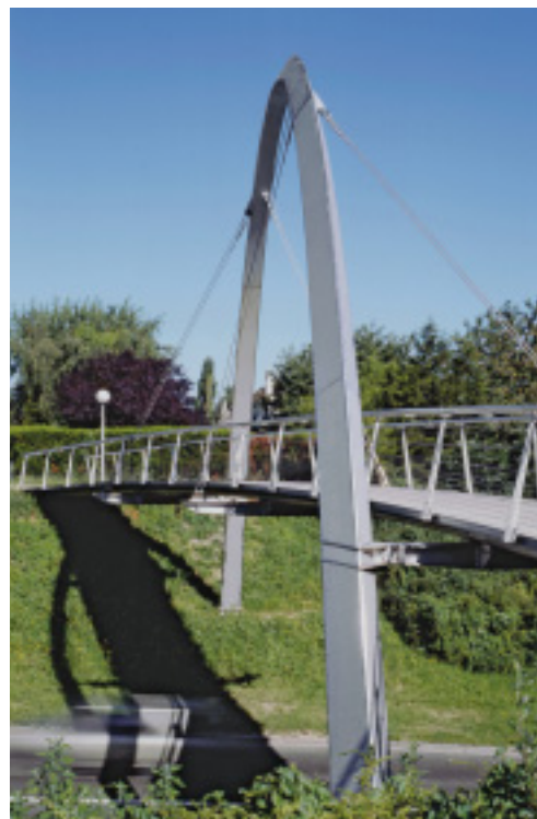
La sezione triangolare dell'arco va rastremandosi dalle fondamenta fino al vertice.
