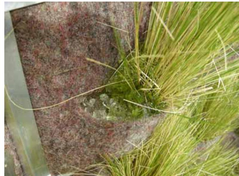
Fig. 3 – A sinistra in basso: il pannello modulare **Reviwall®** è costituito da un telaio in alluminio anodizzato dove è inserita una geostuoia tridimensionale in polipropilene avvolta da due diversi teli drenanti. Dentro la geostuoia si iniettano fibra di cocco idrata, polimeri idroretentori ed inoculi di consorzi micorrizici e batterici per favorire la radicazione e lo sviluppo delle piante.
